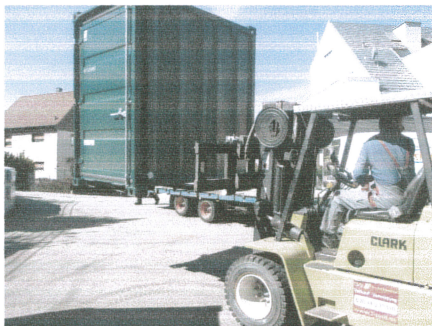
Diese eSaver Anlage hat eine Leistung von 125 kVA
